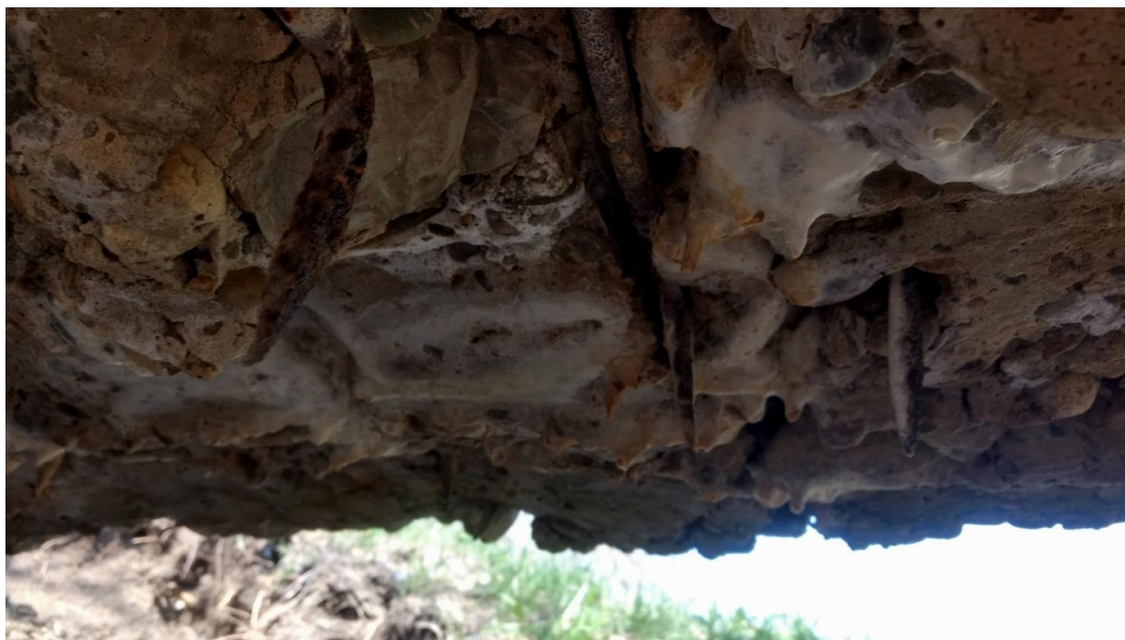
Внутренняя сторона верхнего перекрытия ЖБОТ № 2 с выступающими металлическими скобами
